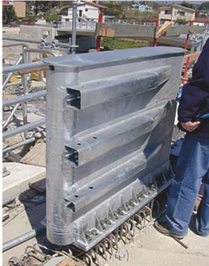
Photo 2 : mise en place de l'élément spécial de BN4 au bord du joint
